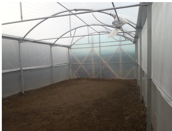
Figura 4 – Sistema automático de abertura de janela
