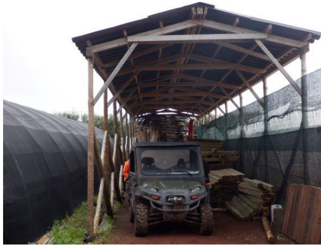
Figura 6 – Casa de abrigo com respetivo corta-vento
