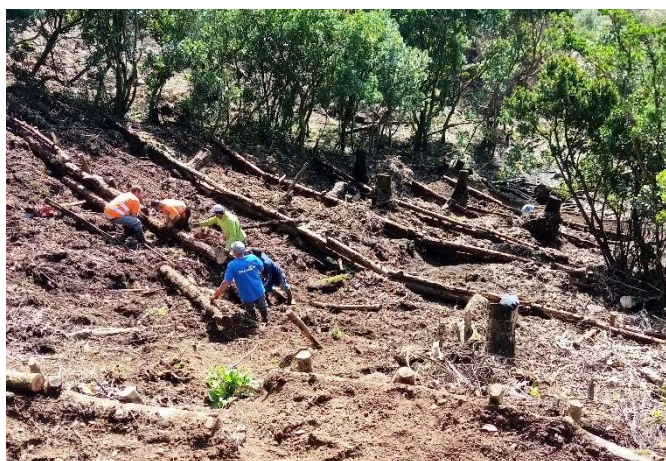
Figura 36. Pormenor da estabilização do solo na área cortada, sendo visível alguns dos cepos das criptomérias cortadas (outubro, 2022).
