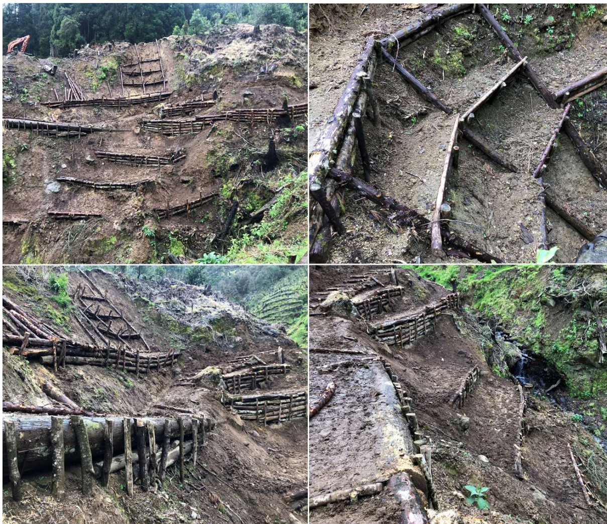
Figura 39. Estruturas de engenharia natural para consolidação de margens de linhas de água, na secção parcialmente intervencionada.
