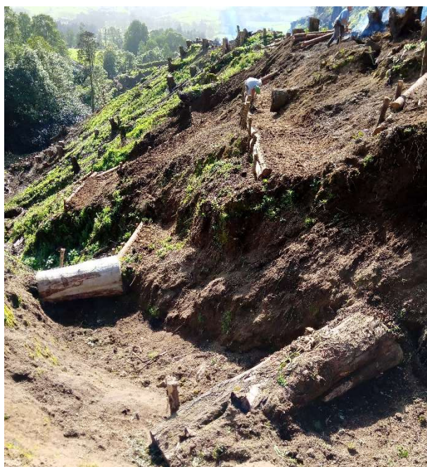
Figura 16. Instalação de micro-açudes ao longo do leito de um dos afluentes da Ribeira da Lomba Grande (março, 2023)
