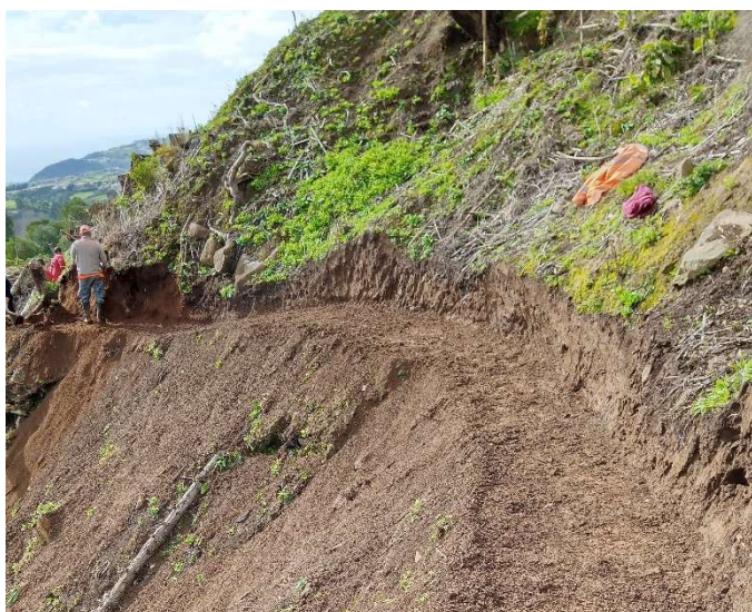
Figura 18. Pormenor dos trabalhos de abertura do trilho ao longo do talude da Ribeira da Lomba Grande (janeiro, 2023)
