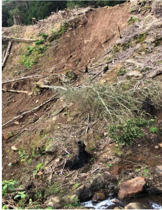
Figura 14. Derrocada nas margens da ribeira, ocorrido após as operações de remoção de EEI's.
