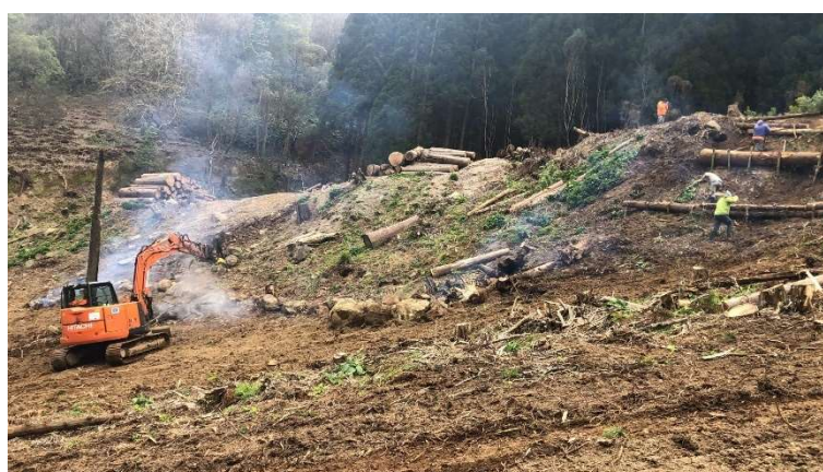
Figura 26. Trabalhos de consolidação das encostas com a instalação de socacos quer com madeira de forma manual, quer com rochas com a utilização da giratória (abril 2022).
