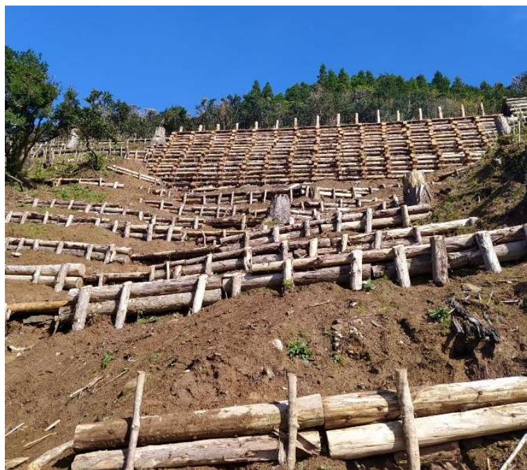
Figura 44. Visão a partir da base de toda a intervenção terminada ao nível da construção das diversas técnicas de engenharia natural projetadas para o local, dezembro de 2023.
