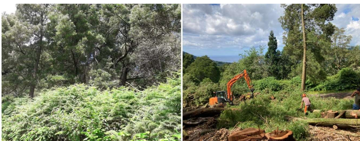
Figura 24. Área de intervenção nos momentos antes (esquerda) e após o controlo de EEI.
