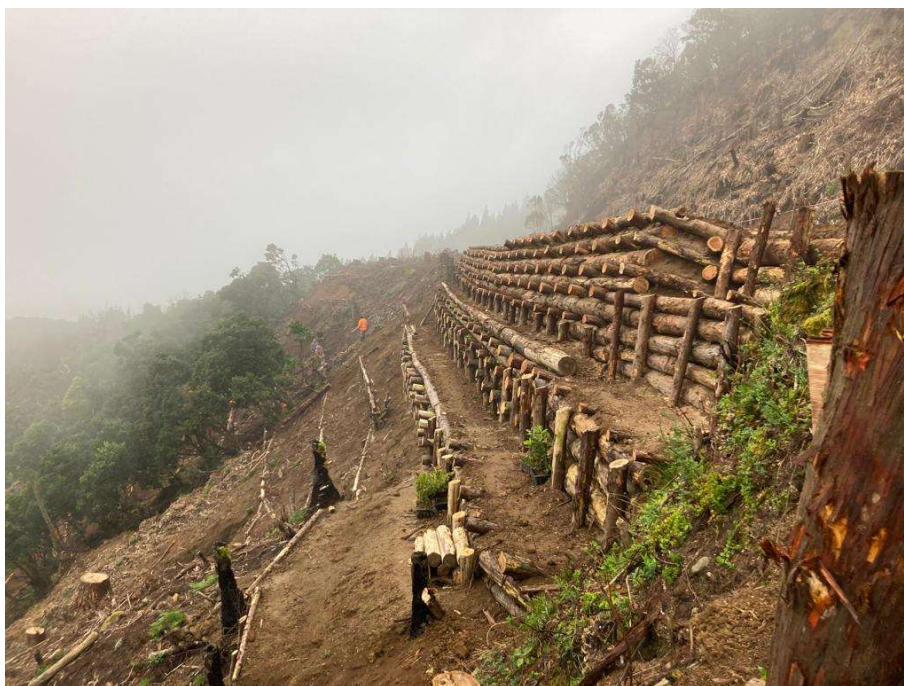
Figura 41. Visão da intervenção terminada em janeiro de 2023, sendo possível ver o muro-vivo em patamares e as paliçadas
