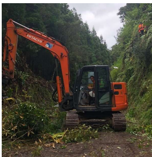
Figura 32. Trabalhos de remoção de resíduos florestais de vegetação exótica no povoamento de ciptoméria na área central da Mata dos Bispos (outubro 2021).
