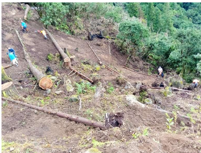
Figura 10. Construção de paliçadas em clareira com vista a controlar a erosão do solo e auxílio à instalação dos povoamentos (novembro 2023)
