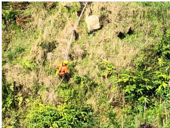
Figura 11. Trabalhos em altura com objetivo de controlo de EEi's, em talude nas margens da ribeira (setembro 2021)
