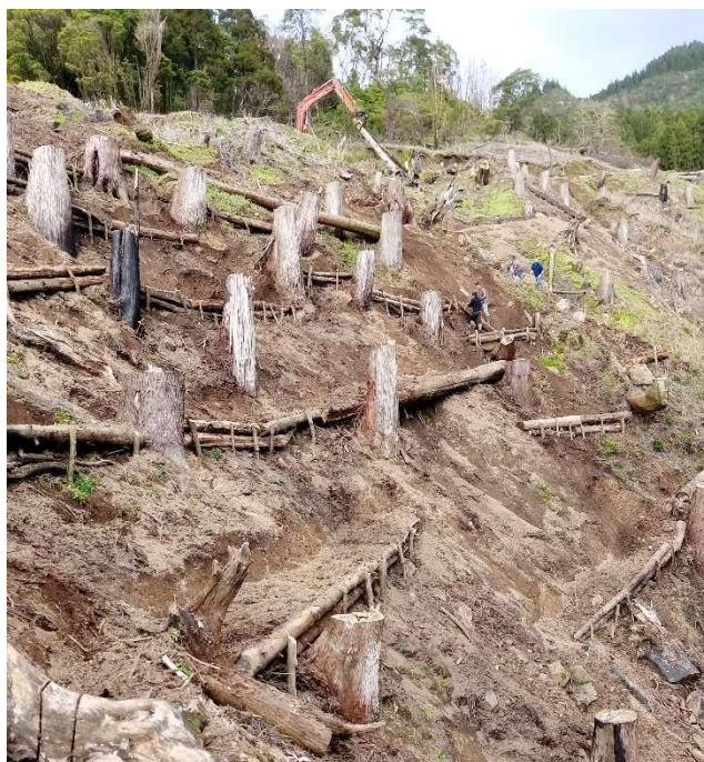
Figura 15. Construção de estruturas de contenção do solo, ao longo dos taludes das margens da Ribeira da Lomba Grande (fevereiro 2023)
