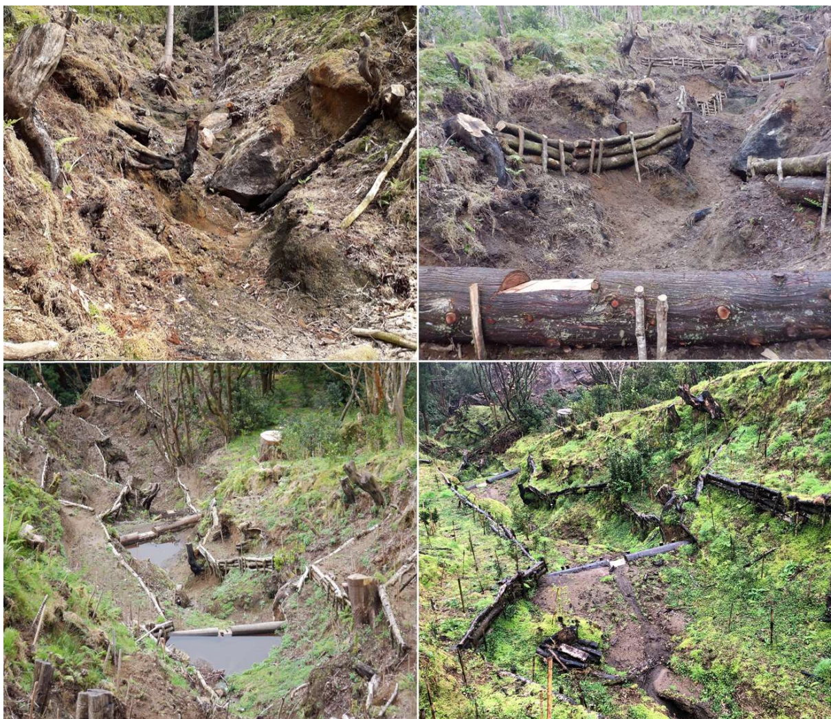
Figura 22. Intervenção da linha de água em quatro diferentes etapas 1: após controlo de EEI (acima, à esquerda); 2: Início da instalação das estruturas de engenharia natural (acima, à direita); 3: margens e leito da linha de água estabilizadas (abaixo, à esquerda); 4: linha de água com margens plantadas.
