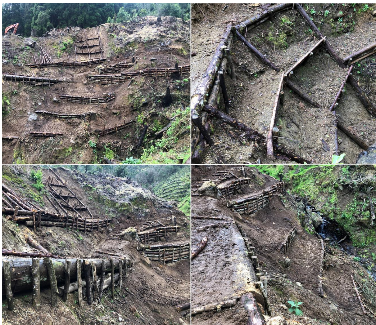
Figura 15. Estruturas de engenharia natural para consolidação de margens de linhas de água, na secção parcialmente intervencionada.
