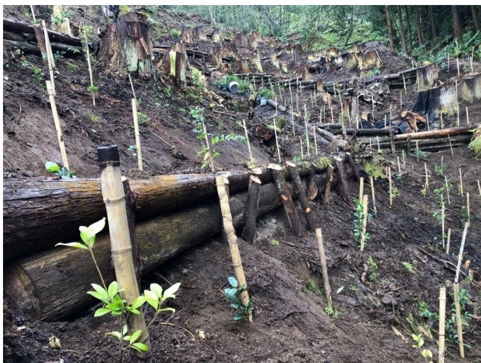
Figura 25. Plantação com espécies autóctones recentemente realizada nas estruturas de engenharia natural.
