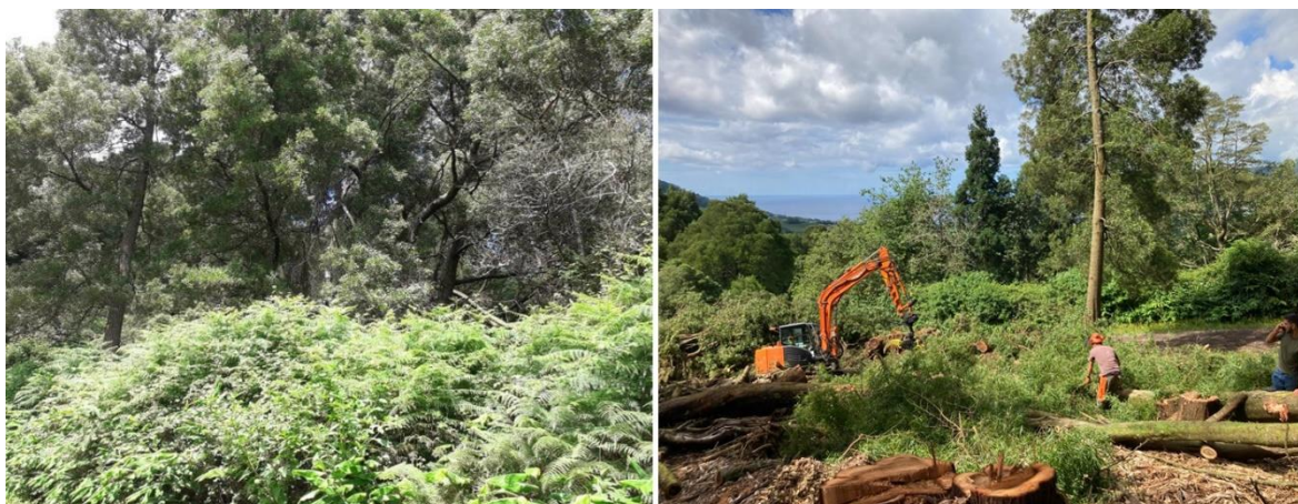
Figura 23. Área de intervenção nos momentos antes (esquerda) e após o controlo de EEI.
