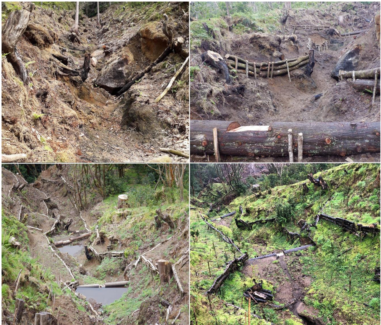
Figura 18. Intervenção da linha de água em quatro diferentes etapas 1: após controlo de EEI (acima, à esquerda); 2: Início da instalação das estruturas de engenharia natural (acima, à direita); 3: margens e leito da linha de água estabilizadas (abaixo, à esquerda); 4: linha de água com margens plantadas.
