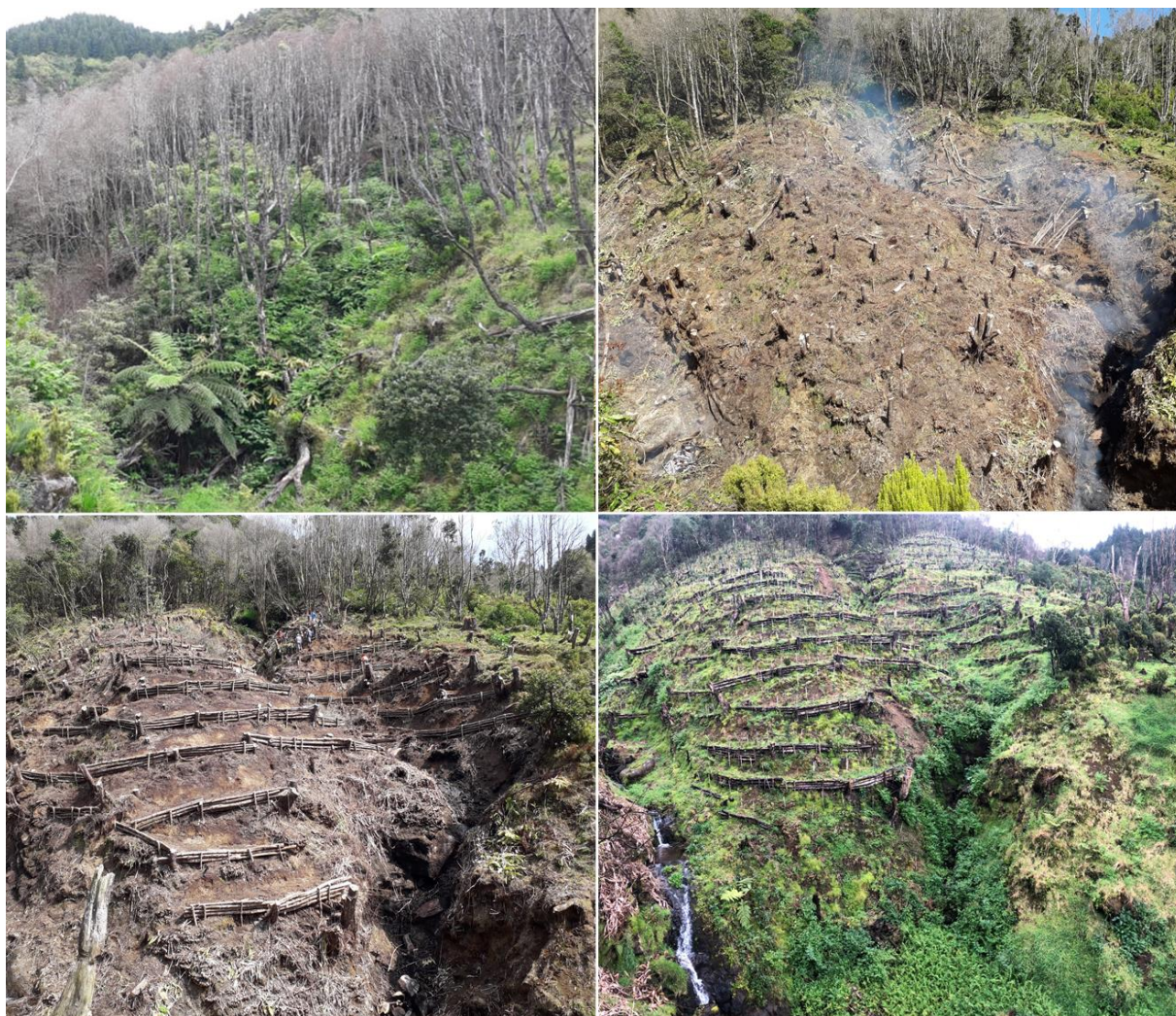
Figura 27. Intervenção de floresta dominada por P. undulatum em quatro diferentes etapas 1: controlo de incenso pela técnica de morte em pé (acima, à esquerda); 2: controlo de EEI no subcoberto e corte raso do incenso (acima, à direita); 3: estabilização dos taludes com engenharia natural (abaixo, à esquerda); 4: área plantada com espécies autóctones.
