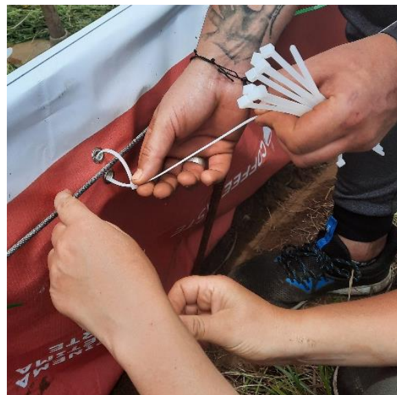
Figura C.9. Colocação e fixação da lona aos varões e ao cabo de aço, utilizando braçadeiras e ilhós de metal. Os ilhós foram colocados com máquina própria de aplicação manual.
