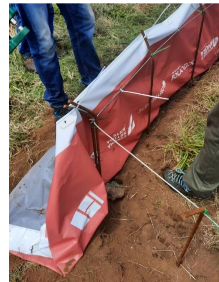
Figura C.9. Colocação e fixação da lona aos varões e ao cabo de aço, utilizando braçadeiras e ilhós de metal. Os ilhós foram colocados com máquina própria de aplicação manual.
