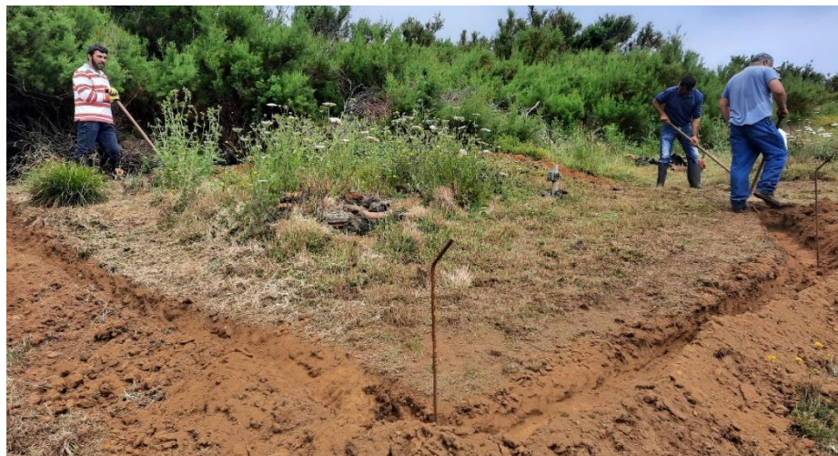
Figura C.7. Escavação de vala ao longo do perímetro da área de exclusão, para depois enterrar parte da lona.
