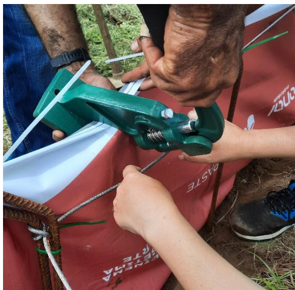
Figura C.9. Colocação e fixação da lona aos varões e ao cabo de aço, utilizando braçadeiras e ilhós de metal. Os ilhós foram colocados com máquina própria de aplicação manual.
