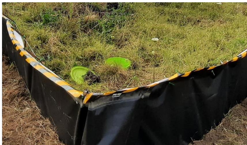
Figura C.11. Colocação de fita refletora de sinalização na parte superior da vedação.
