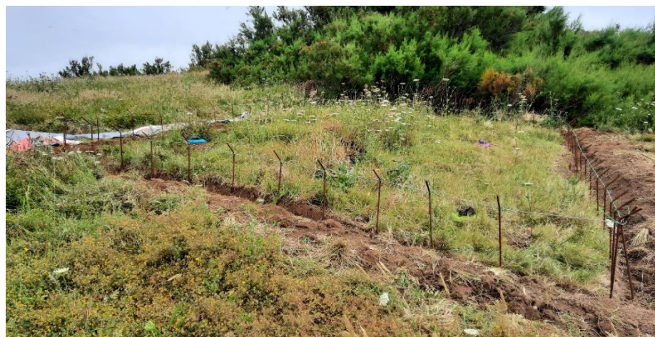
Figura C.8. Colocação dos varões de ferro (50 em 50 cm) e do cabo de aço ao longo do perímetro da área de exclusão.
