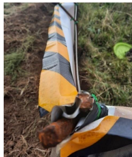
Figura C.11. Colocação de fita refletora de sinalização na parte superior da vedação.
