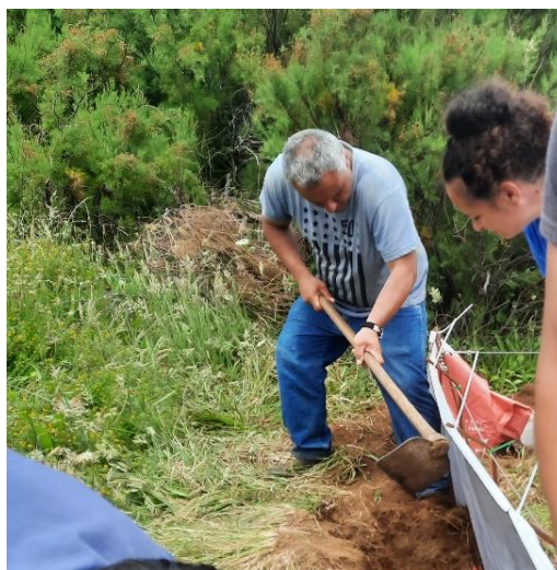
Figura C.10. Parte inferior da lona, junto ao solo, dobrada para o lado exterior da área de exclusão, e soterrada.
