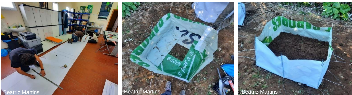
Figura 12. Fase de teste em São Miguel: construção das vedações-teste com lona de impressão (fotos da vedação nº. 3, descrita anteriormente): preparação e medições da lona para montagem no terreno (à esquerda); montagem da vedação com varões a cada 50 cm, e com 30 cm de lona para soterrar (ao meio); resultado final, com colocação de terra para tapar a lona dobrada (à direita).
