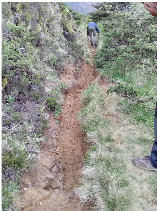
Fig. 21. O local da imagen apresenta uma erosão considerável e que com a chuva torna-se muito escorregadio.
