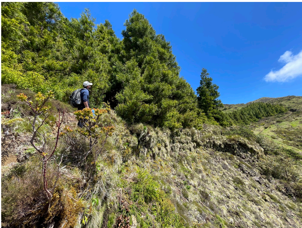
Fig. 26. Plantação de criptomérias colindante com uma derrocada. A imagem dá para perceber que o trilho passa muito próxima da derrocada.
