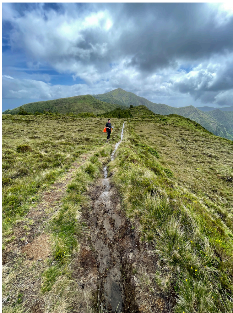
Fig. 19. Devido à inclinação e à compactação com o pisoteio, o trilho encontra-se por baixo do nível de drenagem, e o trilho funciona como vala de drenagem, juntando lama e zonas alagadas e provocando a criação de trilhos alternativos.
