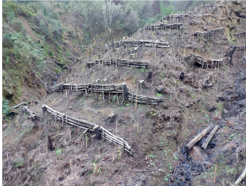
Fig. 43. Engenharia biofísica com sistema de paliçadas e plantação de espécies endémicas para o restauro da Mata dos Bispos.
