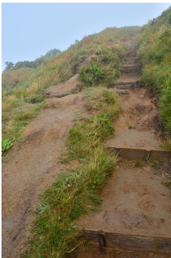
Fig 10. Criação de caminho alternativo devido um troço enlameado no traçado original do trilho. Nesta imagem é possível perceber um significativo impacto sobre a vegetação na borda do trilho.
